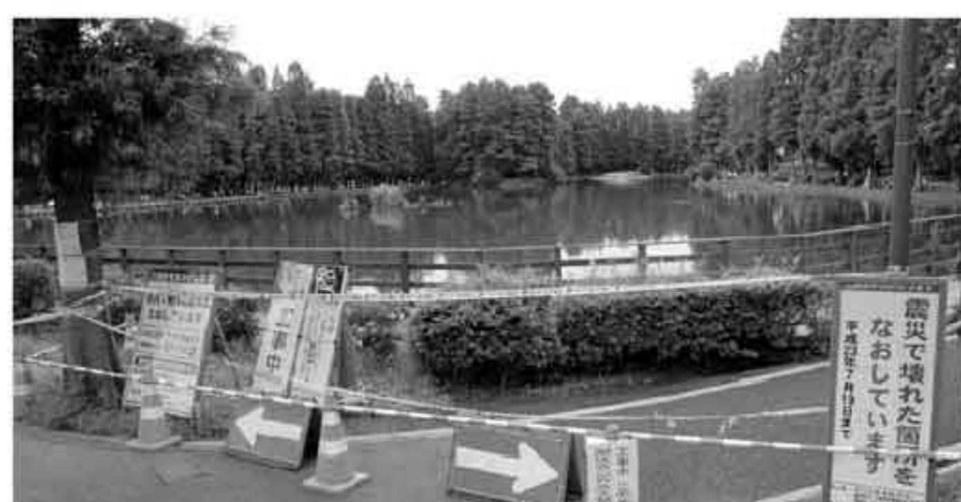
▲震災で被害を受けた別所沼公園(詳しくは中面「南区トピックス」参照)
